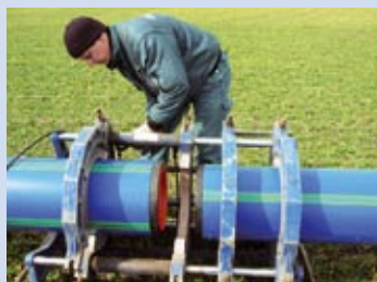
Letzte Arbeiten an der neuen Trinkwasserleitung
