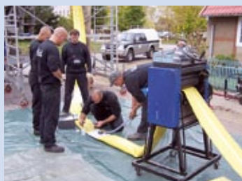
Sanierung Abwassernetz Hanshagen
