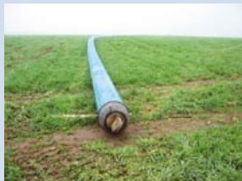
Die neue Trinkwasserleitung zur Insel Usedom
