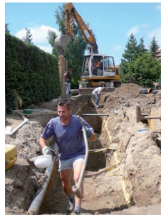
Trink- und Abwasserleitung Gartenweg Neuenkirchen
