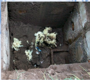
Dieses Bild zeigt dagegen einen unzugänglichen Wasserzähler.
