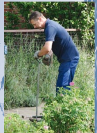
Mitarbeiter Herr Glawe bei Rohrnetzarbeiten.
